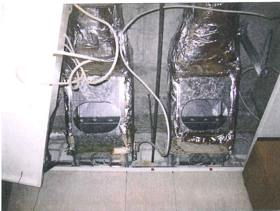
Einbauort der sanierten Brandschutzklappen (Büroräume)
